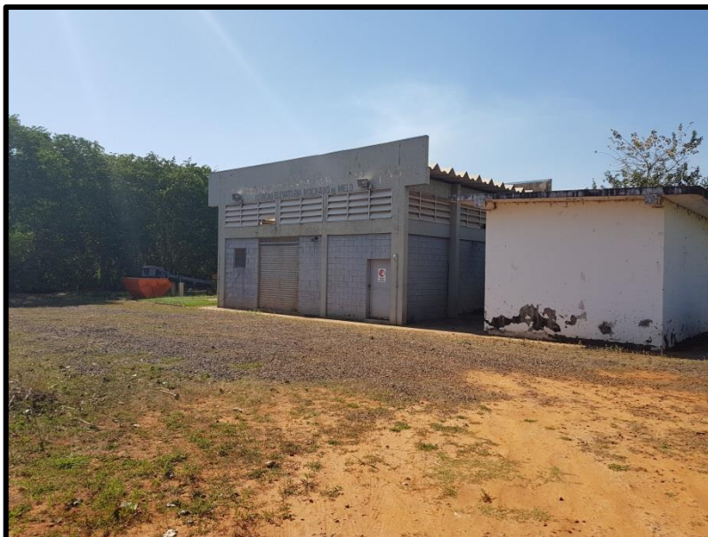
Estação Elevatória de Esgoto Machado de Melo Recebe esgotos da região nordeste e recalca para a ETE Bagaçu
