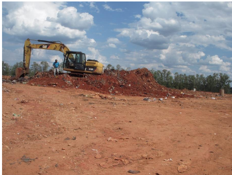
Aterro Sanitário Municipal Execução do tratamento por cobertura e aterro dos resíduos domiciliares descartados
