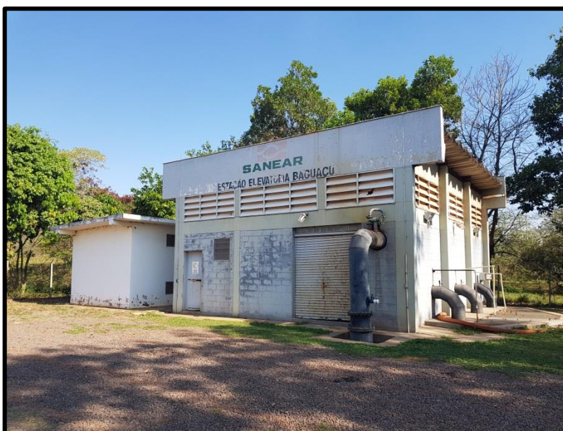
Estação Elevatória de Esgoto Bagaçu Recebe esgotos da região centro e sudeste e recalca para a ETE Bagaçu
