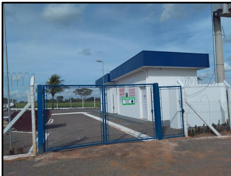
Esgotamento Sanitário Estação Elevatória de Esgoto Santa Isabel (típica) – 2018
