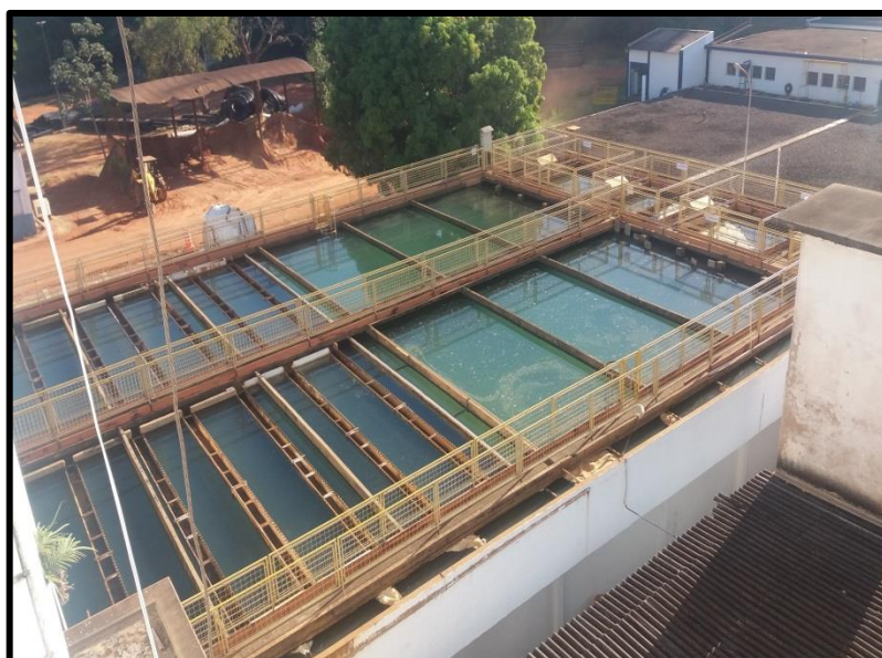
Sistema Produtos Bagaçu Decantadores da ETA Bagaçu – Remodelação em 2018
