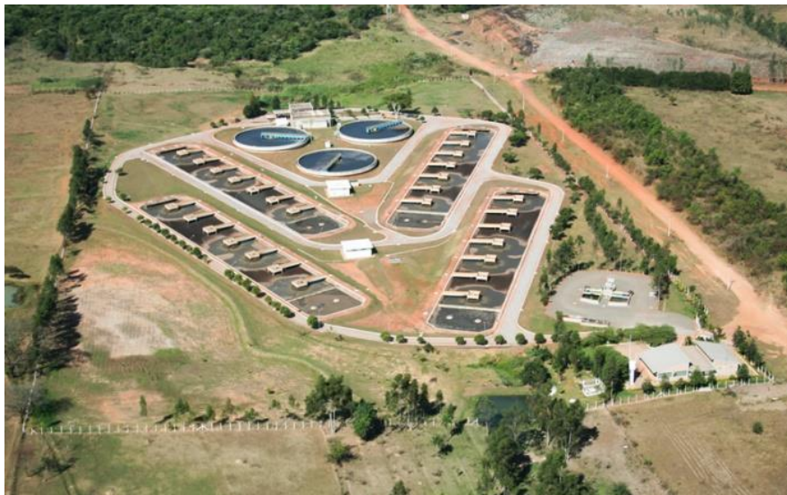
Estação de Tratamento de Esgotos Bagaçu Tratamento de todo o esgoto sanitário de Araçatuba
