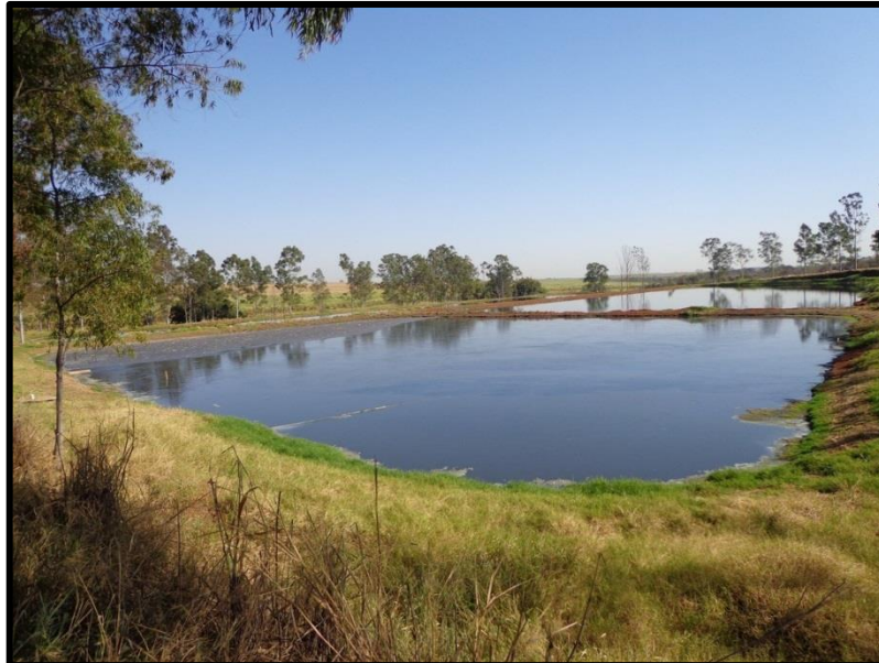
Esgotamento Sanitário Lagoa de Estabilização Maria Isabel – Desativada em 2018
