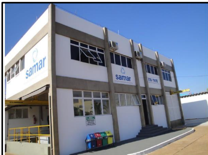
Sistema Produtor Tietê ETA Tietê – Remodelada em 2018
