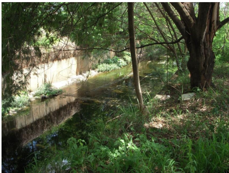
Córrego Machadinho – Próximo à travessia sob a R. Pres. Bernardes Estrangulamento do canal e vão da ponte – Necessita ampliação
