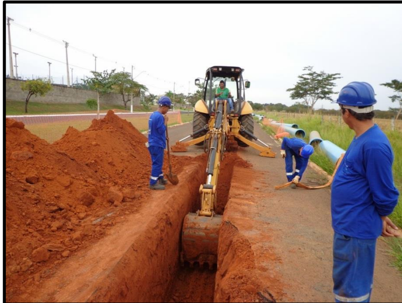
Obras em vias públicas Processo convencional
